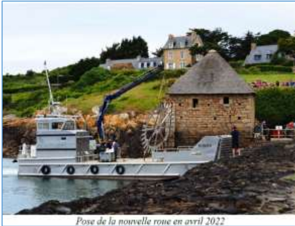
Pose de la nouvelle roue en avril 2022
