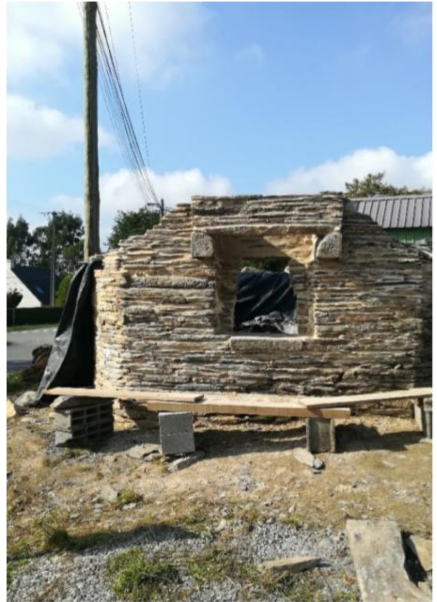
Le four fin octobre. Redémarrage du chantier au printemps 2022
