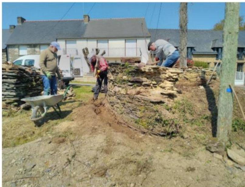
Dégagement du four de la végétation et recherche des fondations
