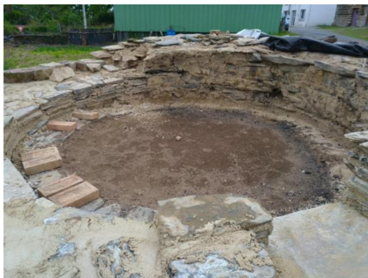
Après avoir gratté l'emplacement de la sole, nous avons retrouvé l'emplacement des briques réfractaires.
