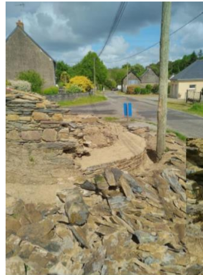
Début de la maçonnerie sur les fondations
